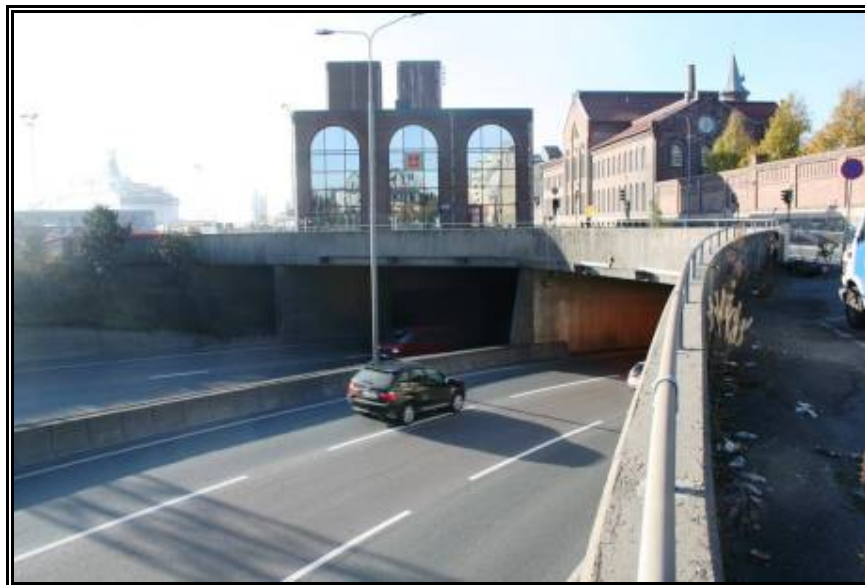
25. A városközpont alatt épített alagút bejárata (fotó: Tosics Iván)
